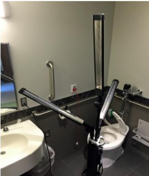
患者用トイレに設置した本体
